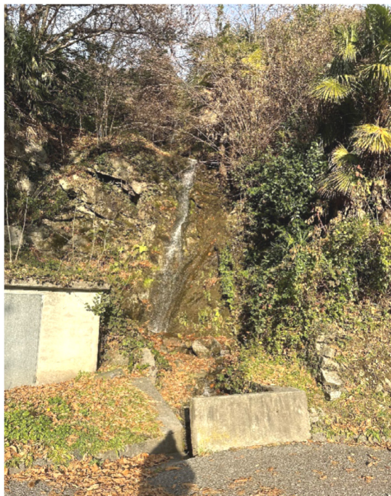
Int. N - Situazione attuale all'imbocco del canale interrato
