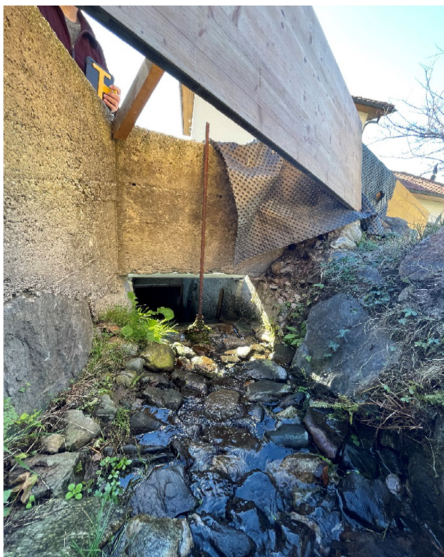
Int. F - Imbocco del canale
