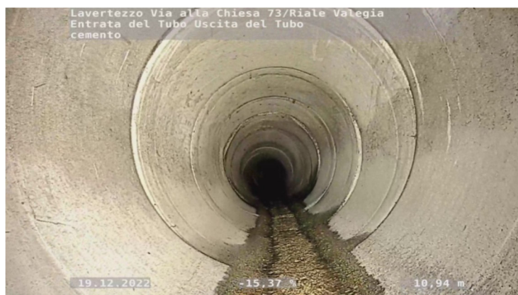
Int. F - Stato del canale interrato
