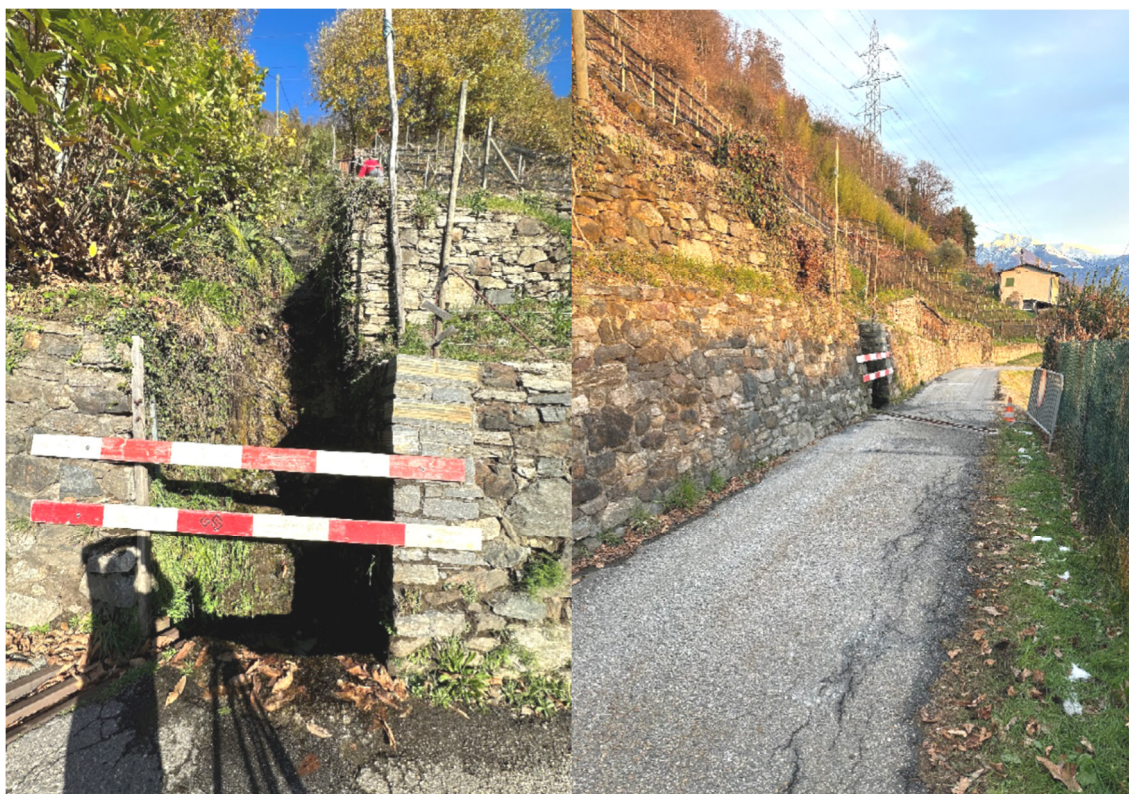
Int. H - Situazione del versante nel luogo previsto per la costruzione della camera da 100 m 3
