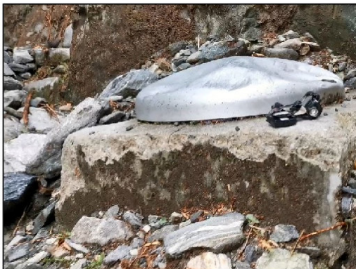
Figura 1-3: Danni manufatto sorgente 30.08.2020
