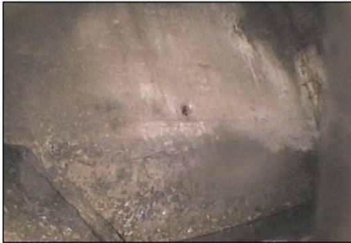
Figura 3-4: Foto Isp-TV parete sinistra zona accumulo (est)
