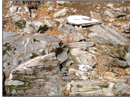
Figura 3-7: Copertura in sassi e cemento
